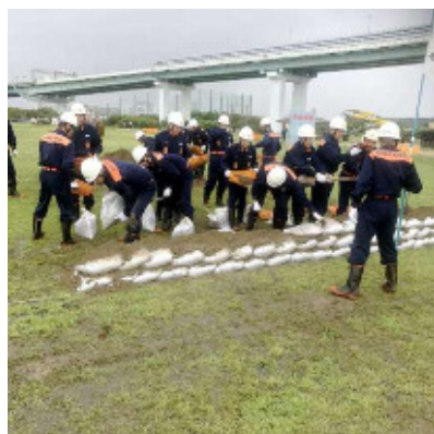
水防工法訓練
