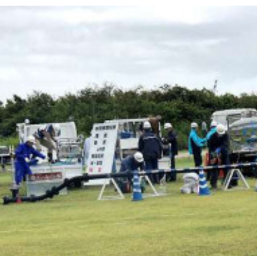
水道施設復旧訓練
