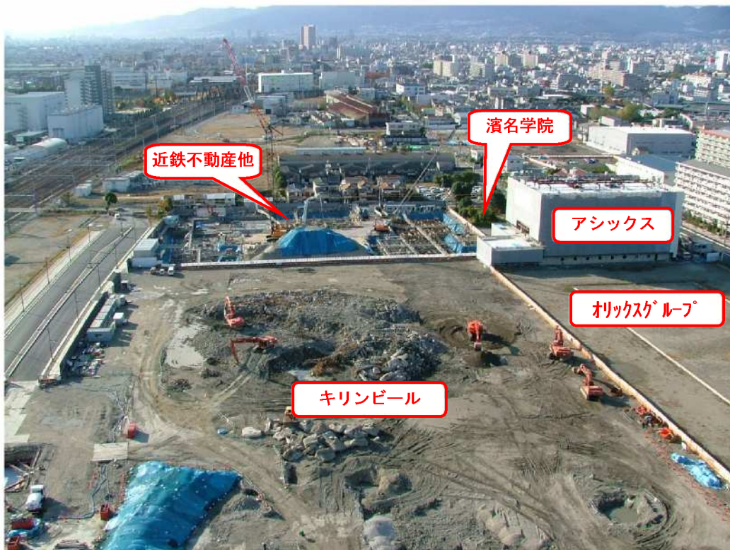
現場写真 (A街区)
