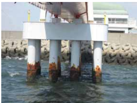
鋼管杭(連絡橋)
