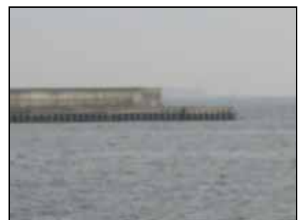
東海岸町先端の護岸(遠景)
