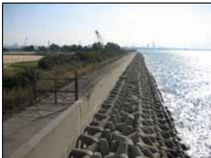
魚つり公園周辺の護岸状況(ナホット)
