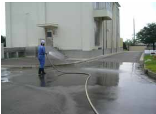
武庫川下流浄化センター
