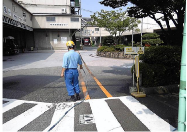
レンゴー(株)尼崎工場
