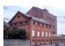
旧阪神電鉄発電所
