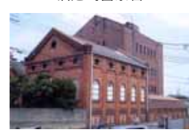
旧阪神電鉄発電所
