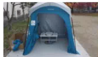
マンホールトイレの設置例
