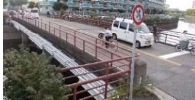
図 4.16 都市計画道路未整備箇所
