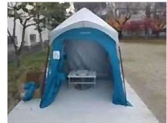
マンホールトイレの設置例
