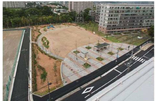
防災機能を有する公園(宮の北公園) (マンホールトイレや雨水流出抑制機能)
