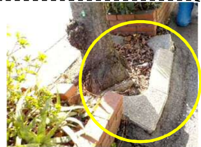
街路樹の根上がり
