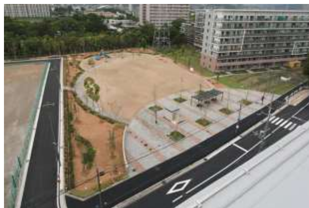
防災機能を有する公園(宮の北公園) (マンホールトイレや雨水流出抑制機能を有する)
