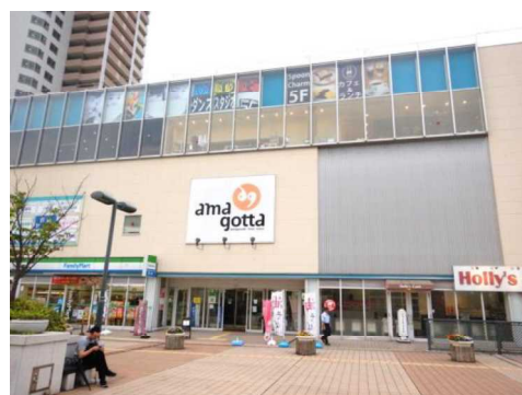
【アマゴッタ北側外観】
