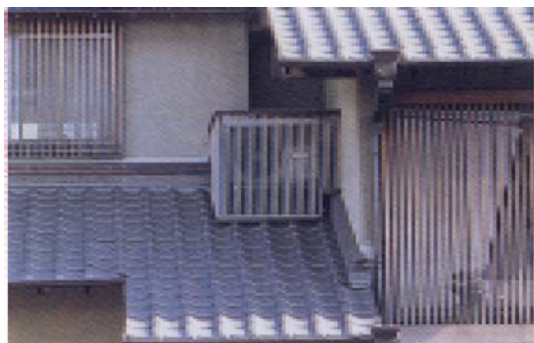
●下屋上の室外機を窓と同じ格子で囲った例（伊丹市）
