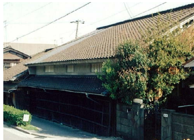
●平入り勾配屋根、下屋の軒、格子などがつくる陰影が情緒ある通りを演出してくれます（築地北浜：震災前）
