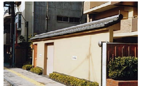
●建物と道路の間に、和風塀をたてることによって、まち並みへ配慮している例(寺町)
