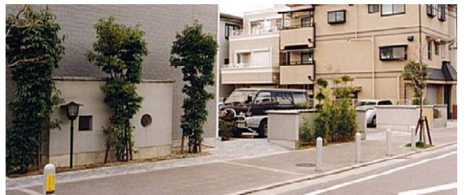
●ブロック塀に瓦を乗せて、ちょっとした緑を配置している例 (築地北浜)
