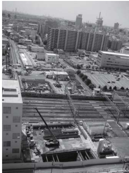
長洲久々知線立体交差事業(平成24年3月)
