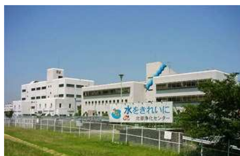
北部浄化センター
