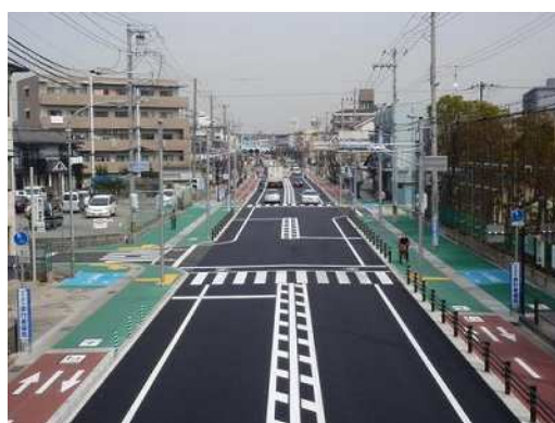
自転車道（車道の両端の部分）
