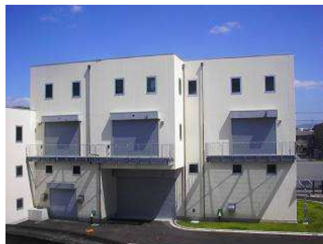
汚泥脱水施設
