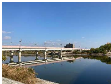
図 4.7 阪急神戸本線武庫川橋りょう
