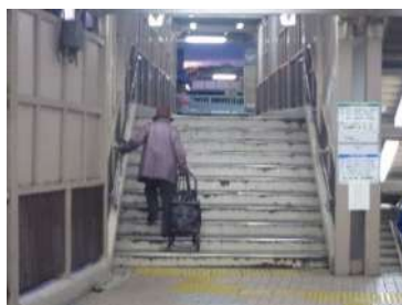
図 4.26 バリアフリー化未整備箇所（立花陸橋）
