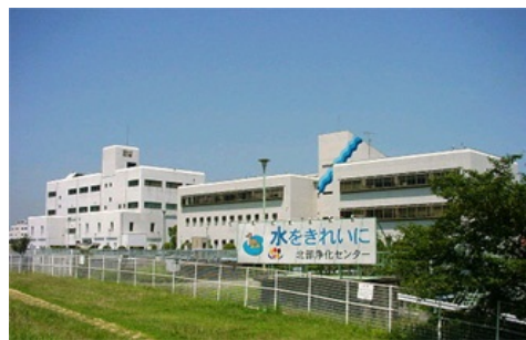
北部浄化センター
