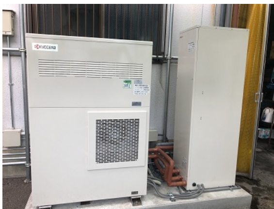
設置された燃料電池 ユニオンフーズ（株）
