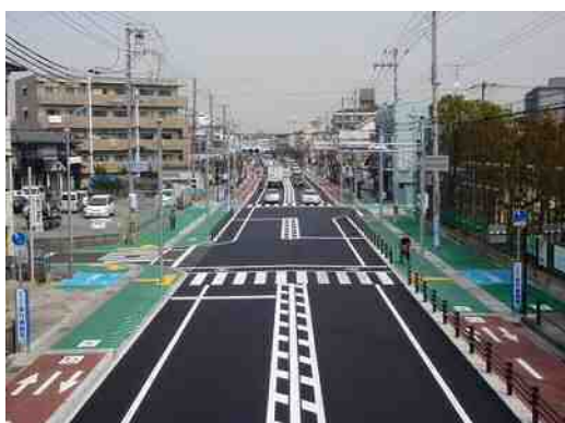
自転車道（車道の両端の部分）
