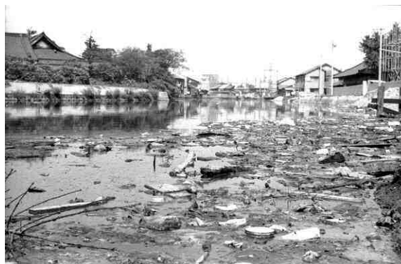
地盤沈下のため流れが止まり、ゴミのためのようになつた大物川。昭和 40 年代に埋立工事が行われ、現在は緑道公園となっている。（昭和 40 年（1965）、市広報課撮影）
