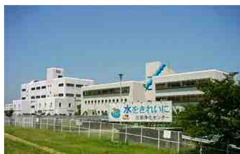
北部浄化センター
