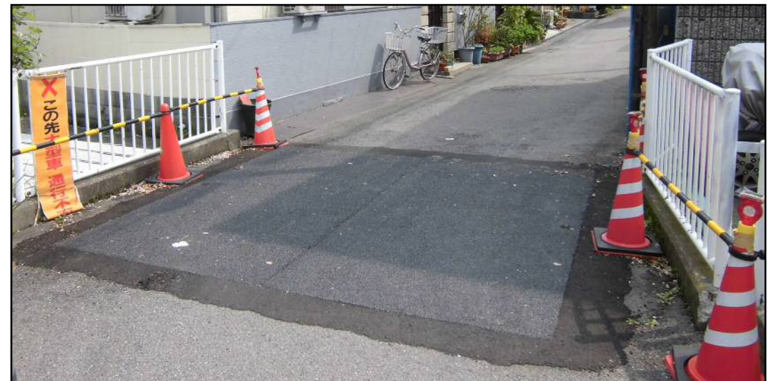
応急措置状況
