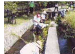
水路清掃の様子（武庫豊町）
