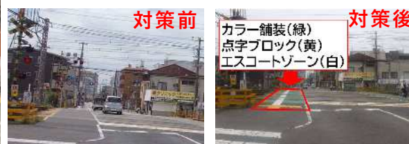
図 4.25 踏切の安全対策
