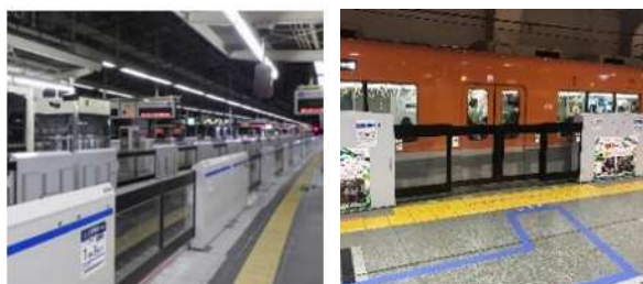
図 4.24 ホーム柵の設置
