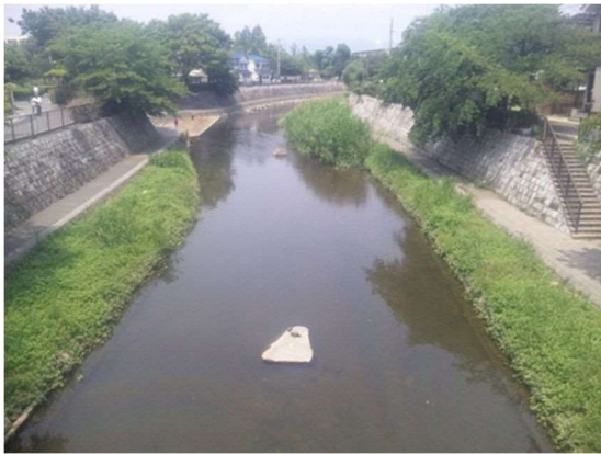
写真 12 庄下川（上生島橋付近）
