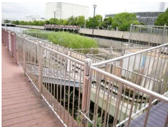
写真16 運河の水質浄化施設
