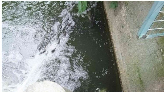
写真6 蓬川南豊池橋直下の水門
