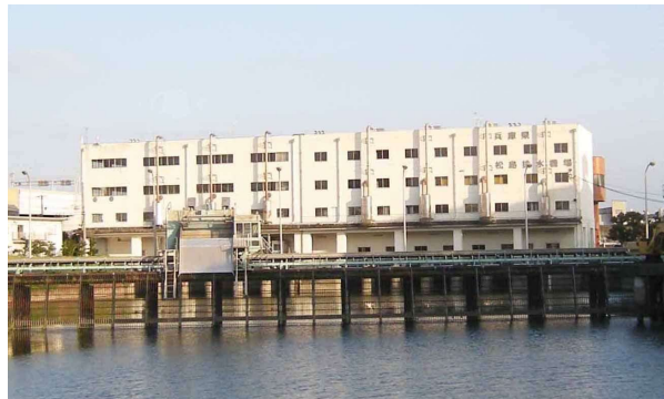
写真8 庄下川河口（松島排水機場）
