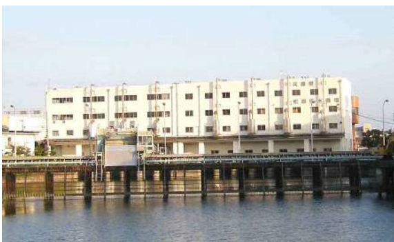
写真8 庄下川河口(松島排水機場)
