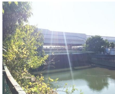
写真2 庄下川庄下川橋
