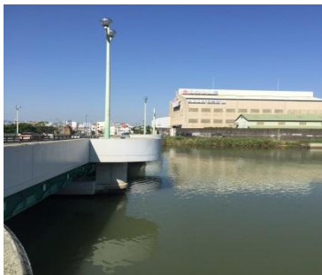
写真1 神崎川左門橋
