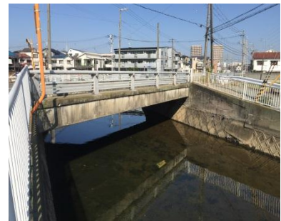
写真3 蓬川南豊池橋
