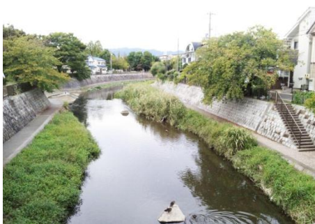
写真4 庄下川上生嶋橋上流
