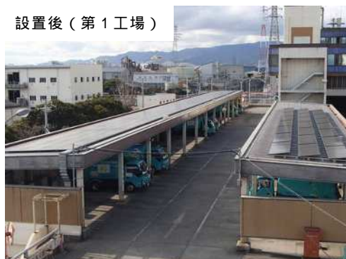
太陽光発電設備設置の過程
