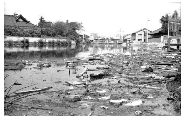
地盤沈下のため流れが止まり、ゴミめつた大物川。昭和 40 年に埋立工事が行われ、現在は緑道公園となっている。(昭和 40 年（1965）、市広報課撮影)
