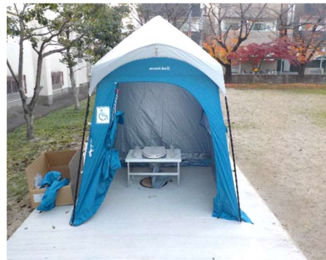
マンホールトイレ
