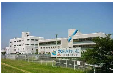
北部浄化センター
