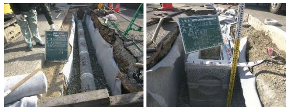
雨水浸透管・雨水浸透ますの設置
