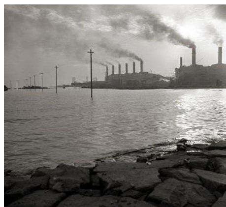
末広町、地盤沈下により道路が海に沈み、電信柱だけが水面に残っている。(昭和 29 年(1954)、村井邦夫氏撮影)
