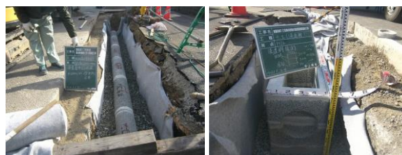
雨水浸透管・雨水浸透ますの設置
