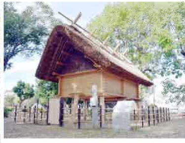
復元高床倉庫（2022年完成）
