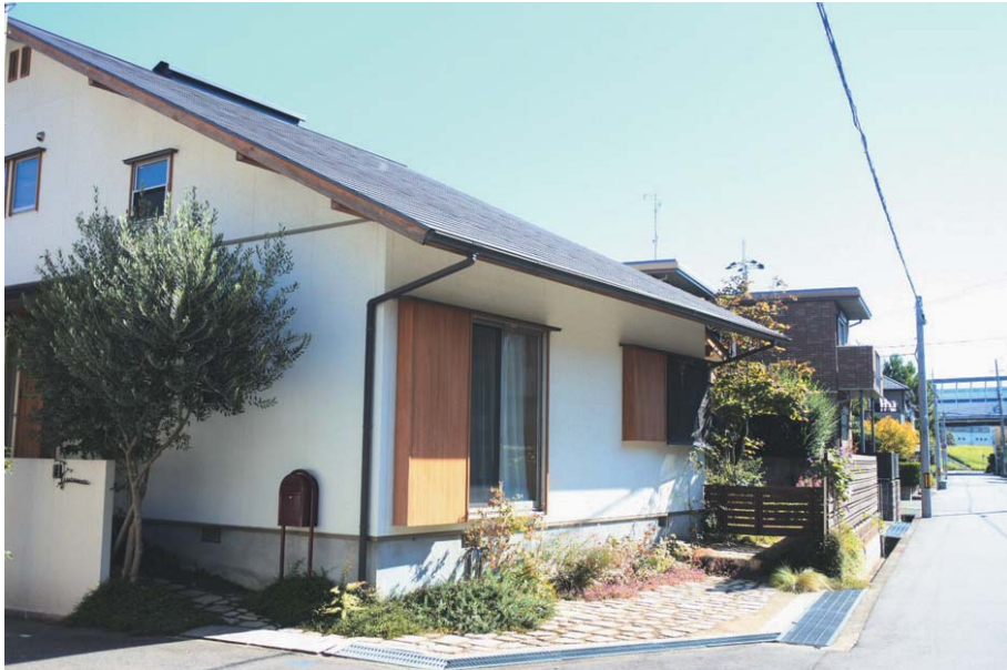
おらかな屋根が特徴的な家と自然素材をふんだんに使った外構がまちかどを演出
